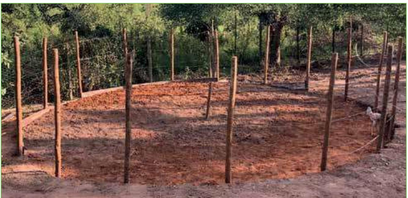
**Figura 3:** Arame liso e tela fixadas às estacas (Lamartine Branquinho)
