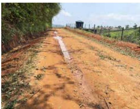
*Construção irregular da bacia de contenção de água de chuva:* na abertura das bacias de contenção, houve rompimento na lateral, que poderia ter sido evitado, se utilizado a parte estabilizada da bacia, que é a parte abaixo do nível da terra firme na captação da água.
