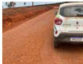
*Equipamento utilizado na compactação:* na utilização do caminhão pipa para compactar os trechos, no lugar do rolo compactador, na primeira chuva aparece uma “laminha”, antes de aparecer o cascalho, causando insegurança aos motoristas. Na finalização com a motoniveladora, passar a lâmina deitada, diminuiu esta ocorrência.
