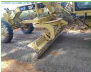
**Figura 69.** Aplicação e distribuição do material.
