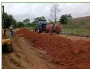
**Figura 43.** Adição de material externo para elevação de nível e conformação do leito da estrada.
