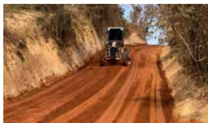
**Obturação:** utilizado na formação de caixa de pó, com substituição do material sem capacidade de suporte por material agregante.
