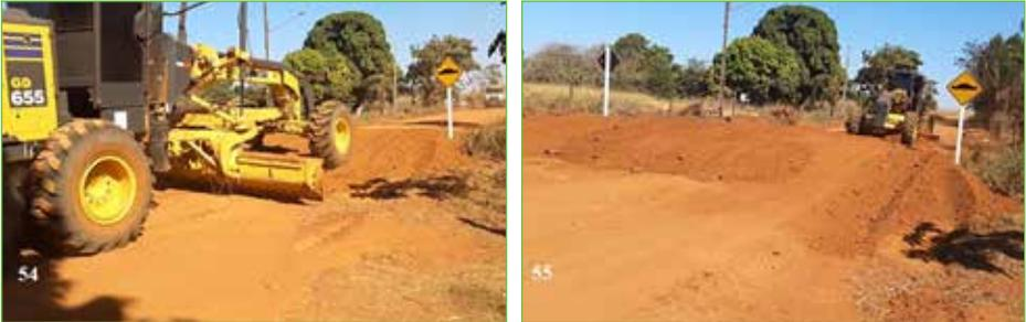
**Figuras 54 e 55.** Ilustração de construção de lombada.
