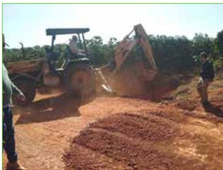
**Figura 57.** Uso de retroescavadeira na construção de bacia de captação de águas pluviais.
