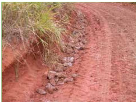
**Figura 56.** Detalhamento de sarjetas (condutor de água pluvial), com pedras sendo utilizada como dissipadores de energia.
