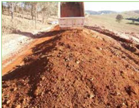
**Figura 47.** Deposição de mistura (solo argiloso e agregado)
