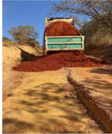
**Sarjetas:** executados no bordo da plataforma, objetivam a coleta das águas de escoamento superficial da pista, conduzindo-as fora da estrada.
