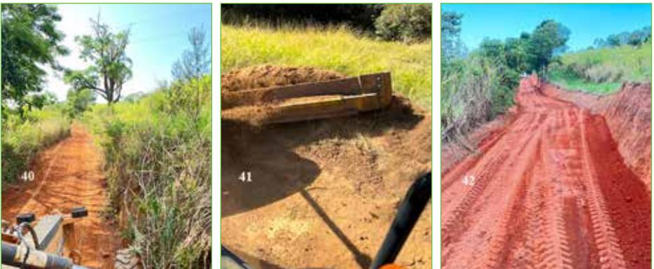
**Figuras 40, 41 e 42.** Limpeza de barranco com aproveitamento de material para conformação do leito da pista.
