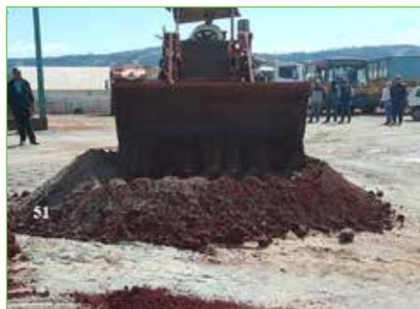
**Figuras 50 e 51.** Solo argiloso e pó de brita sendo misturados
