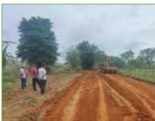
**Figura 44.** Distribuição de material e abaulamento do leito.
