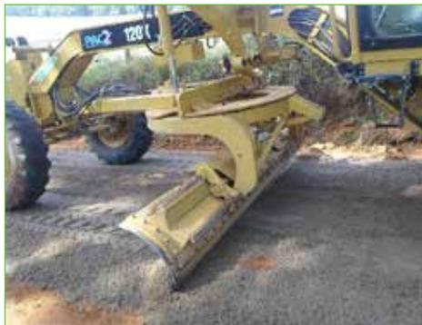
**Figura 46.** Adição de agregado em trecho com solo argiloso.
