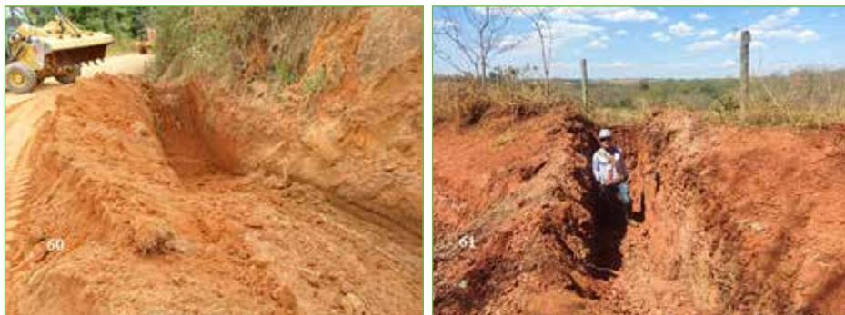
**Figuras 60 e 61.** Demonstração de caixas dissipadoras de energia hidráulica.
