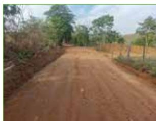
**Figura 45.** Trecho com material compactado/selado.
