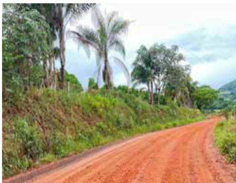
*Mau posicionamento da lâmina da motoniveladora:* o trabalho com a lâmina posicionada de forma inadequada dificulta a caída e direcionamento das águas da chuva para as canaletas.
