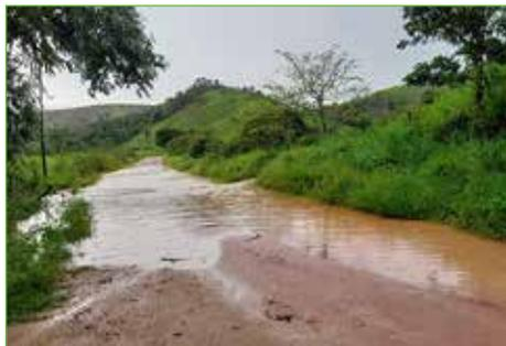
**Figura 8.** Alagamento de estrada, causado pelo escoamento superficial excessivo e pela ausência de controle de drenagem adequado.
